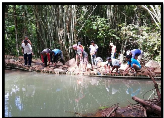
โครงการก่อสร้างฝายน้ำล้น(ฝายมีชีวิต)ห้วยช่องแค ม.๒
